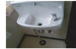
手洗器や洗面台の取替
